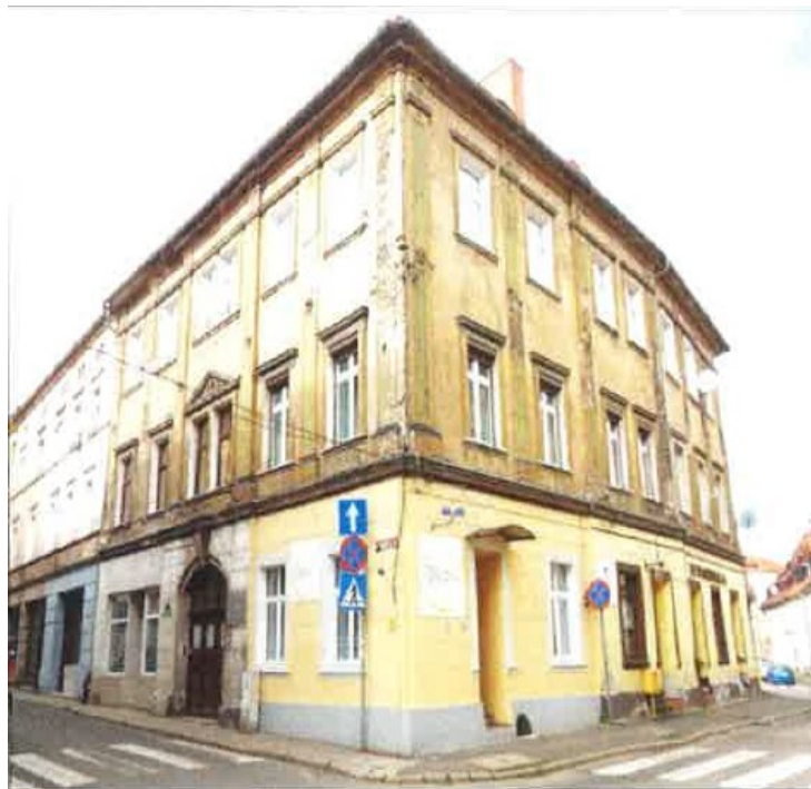
Ogólny widok budynku
